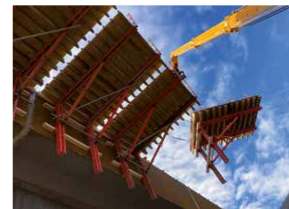
Cassaforma impiegata per il getto dell'impalcato del nuovo ponte in Fase 04.
