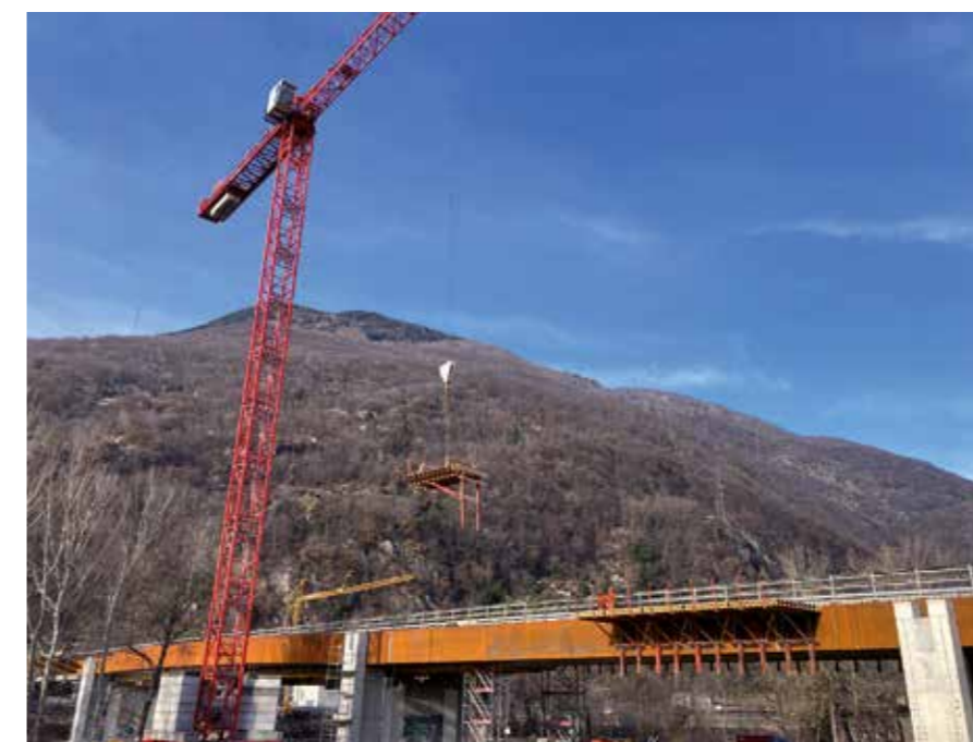
Cassaforma impiegata per il getto dell'impalcato del nuovo ponte in Fase 04.
