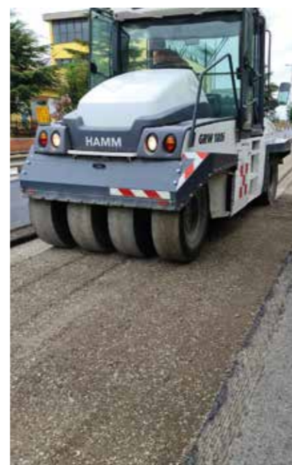
Rullo gommato per compattazione CB rigenerato a freddo.
