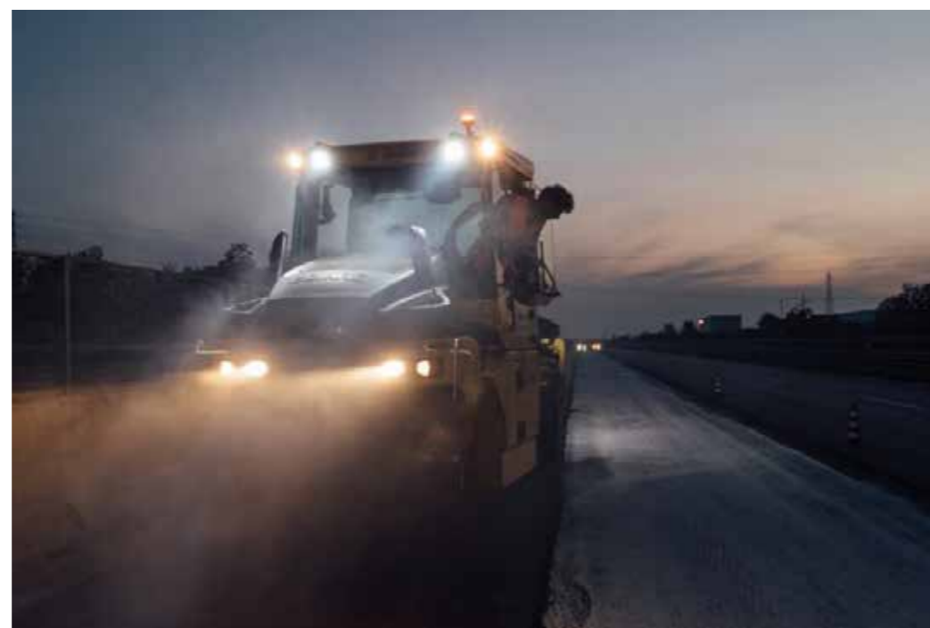
Fig. 3 - Lavori eseguiti sull'Autostrada A4 Brescia-Padova.
