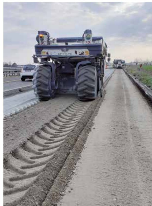
Fig. 6 - Lavori in notturna.
