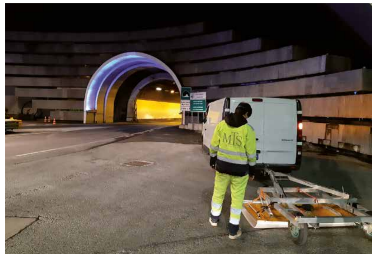
A fianco, il georadar all'ingresso del Traforo del Monte Bianco e, in alto, durante un'indagine per le strade di Milano.
