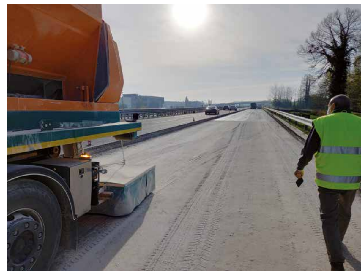
Fig. 9 - Lavori di preparazione del piano di posa degli strati di rinforzo.
